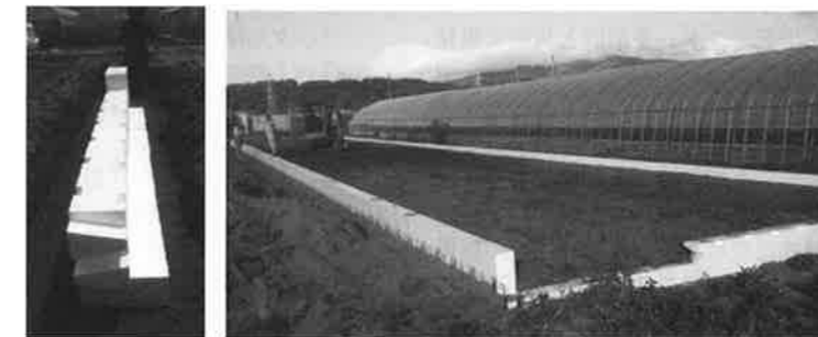
EPSパネルの埋設部を掘削後設置 EPSパネルを全周埋設完了後ビニールハウスを設営
